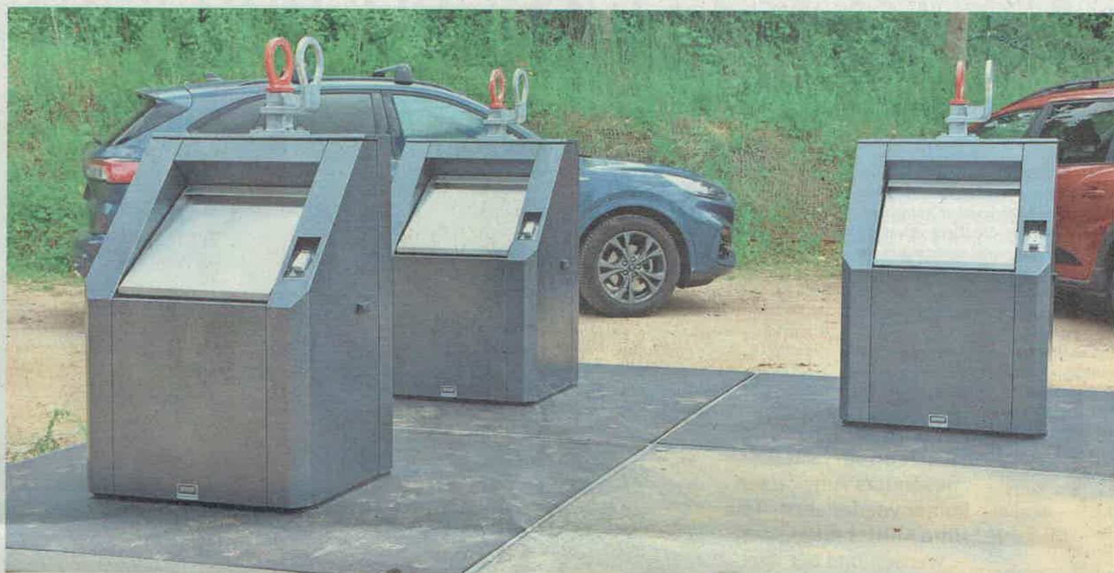
Diese drei Einfüllstutzen – auch zum Beispiel von einem Rollstuhl aus bedienbar – ragen aus der Erde heraus, der größte Teil der Abfallcontainer befindet sich unter der Oberfläche. Das System ersetzt im Prym-Park Düren alle Mülltonnen.
