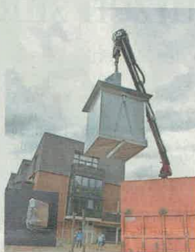
Der erste Container schwebt im Prym-Park ein. Der überwiegende Teil verschwindet im Boden.
