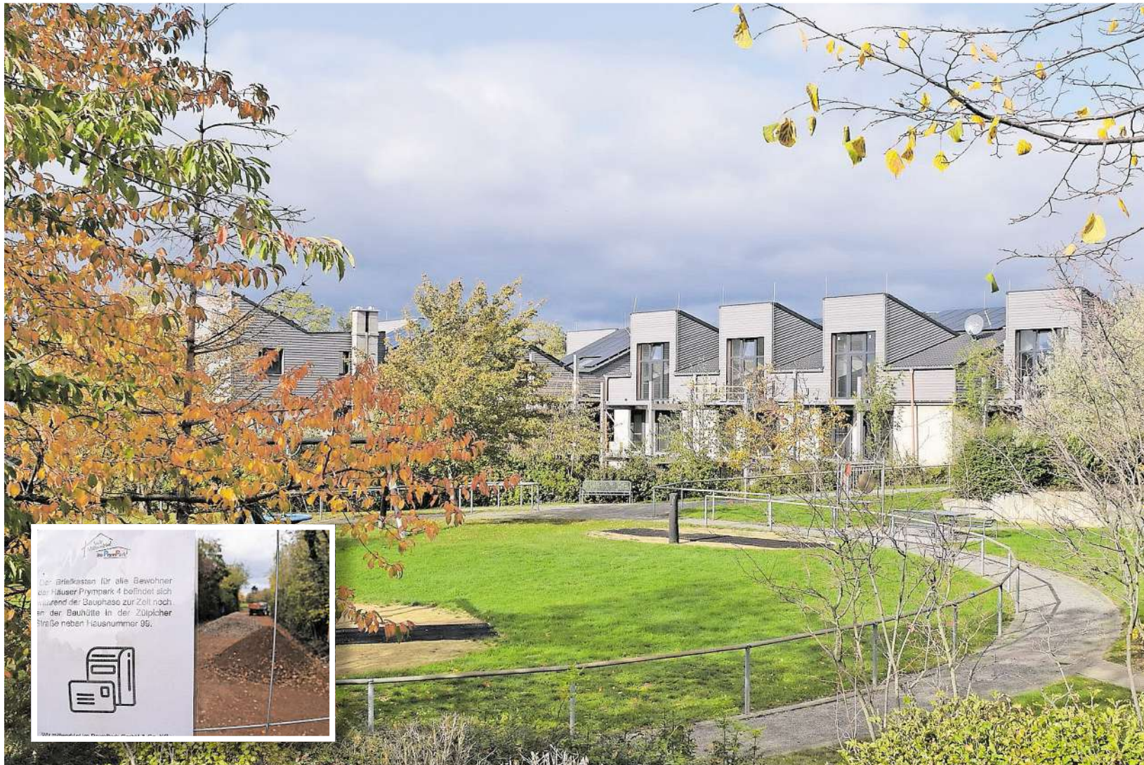
Blick von der Roncallistraße auf das Prympark-Gelände: Die ersten 50 Wohnungen sind so gut wie fertig. Fünf Familien hatten gehofft, bereits im August hier einziehen zu können und hängen seitdem in der Luft. Unter anderem fehlt noch der Anschluss an den Abwasserkanal.
